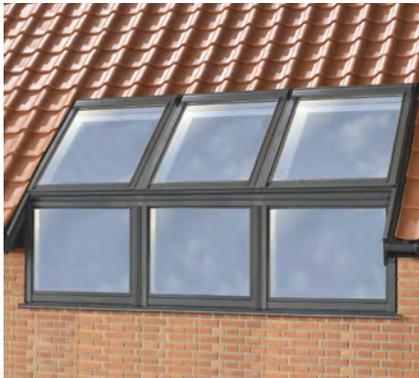
Für den Einbau von zwei oder 3 VELUX Dachfenstern mit VIU/VFE oder VFA/VFB
