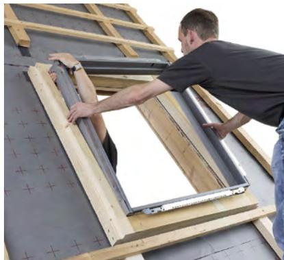
Standard-Einbau mit BDX und Holzstapelrahmen
