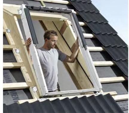
3. Fensterstock in die Dämmung einsetzen und verschrauben.
