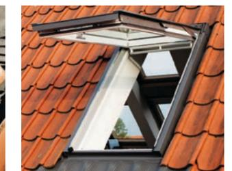
Montage des neuen Eindeckrahmens und Einhängen des neuen Fensterflügels. Fertig!
