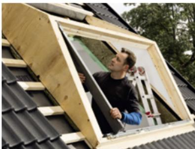
Wärmedämmrahmen BDX einbauen
