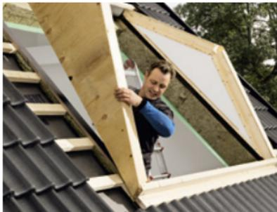
Vorgefertigte Dämmelemente auf Dachlattung montieren
